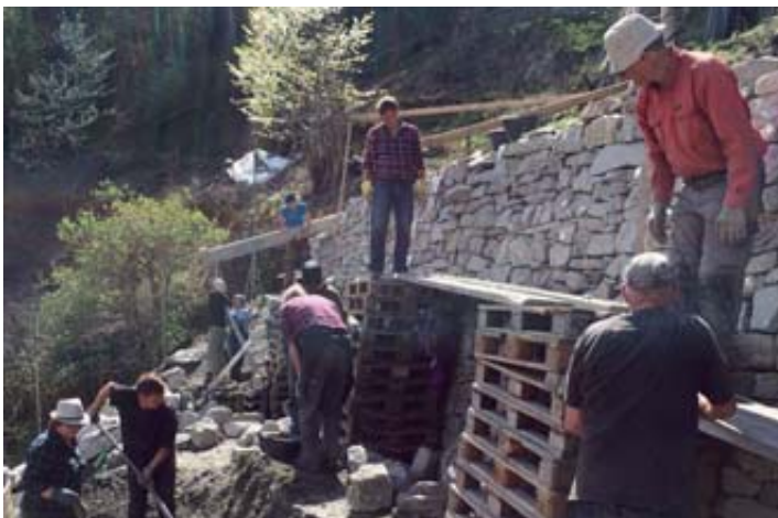
VASTE CHANTIER Les membres de VinEsch ont patiemment refait les murs en pierres sèches (472 mètres de long pour 800 mètres carrés). DR
